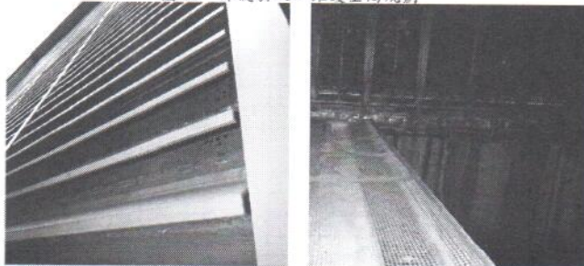
圖 26 外氣引入口汙化與阻塞
